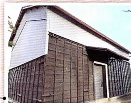
穀蔵 土蔵造平屋建 明治31年(1898)建造
